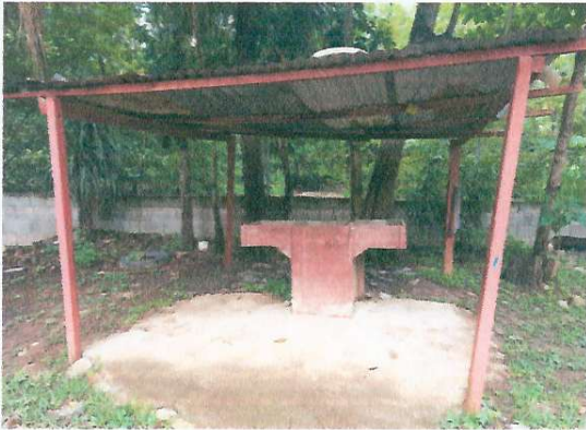
Foto 3: REMOZAMIENTO DE GALERA.
